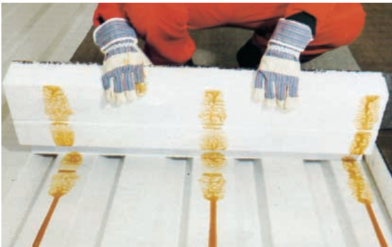
Frische Kleberstränge auf Stahltrapezprofilblech. Durch Auflegen der Klappbahn wird der Kleber auf den Hochpunkten flächig verteilt.
