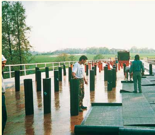
Ausrichten der Bahnen im Versatz
