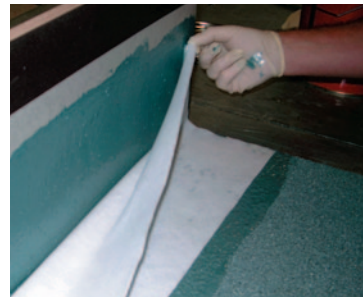
Einlegen des Vlieses
