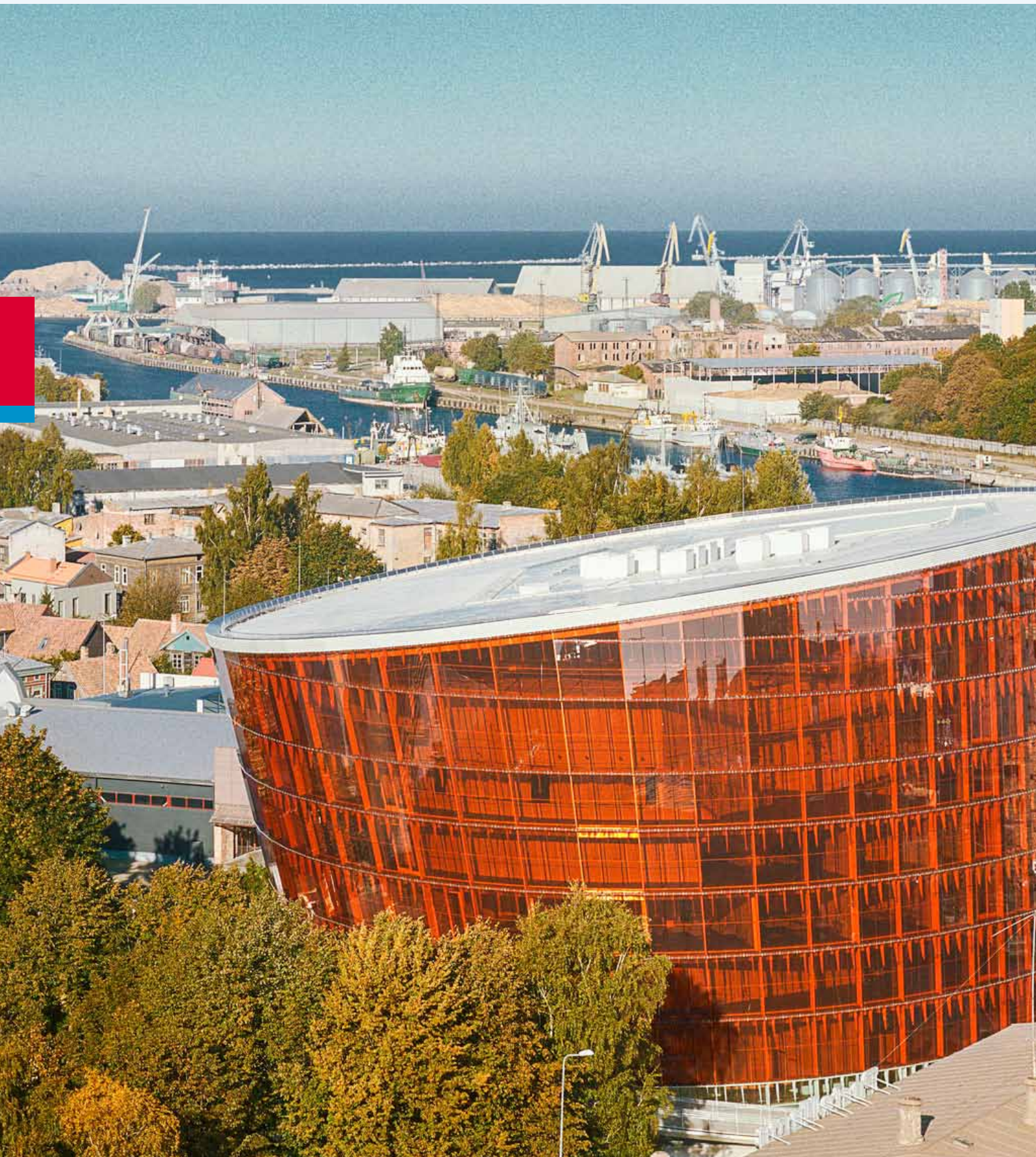
Bild: Great Amber concert hall, Konzertsaal in Liepāja, Lettland, LOGICROOF V-RP 2,0 mm, 3.000 m 2 , 2015
